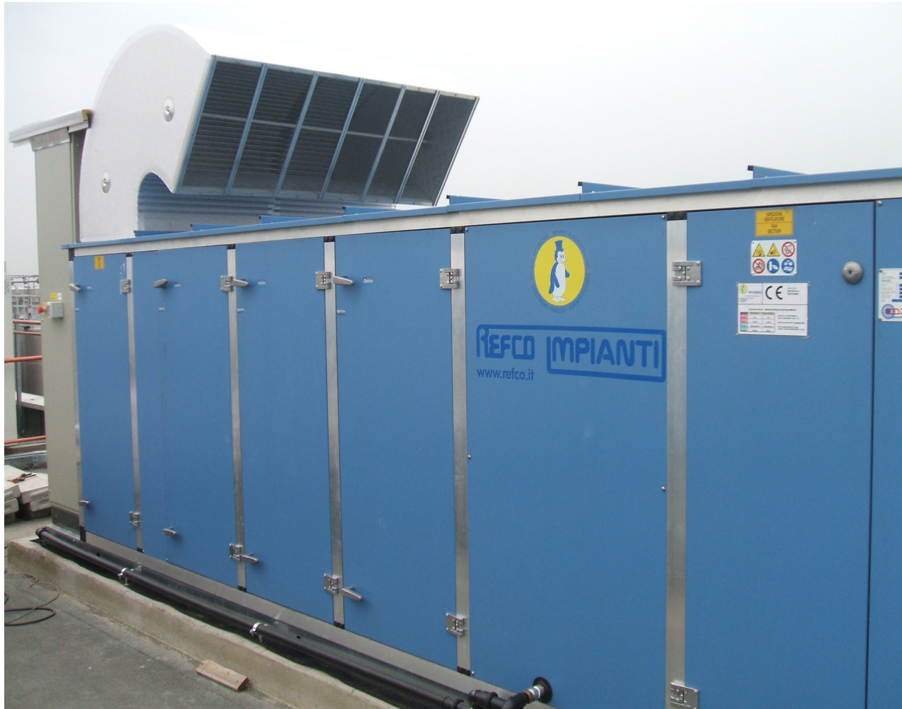
IMPIANTO DI RAFFREDDAMENTO ARIA @ +2°C PER MULINI DI MACINAZIONE
