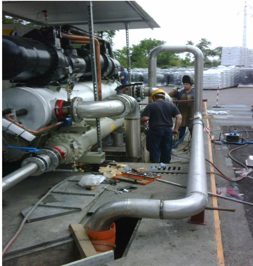
FASE DI COSTRUZIONE IMPIANTO FRIGORIFERO 1200 kWf
