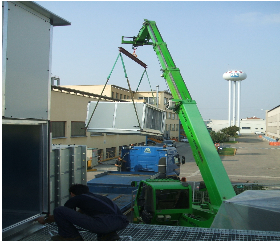
FASE DI INSTALLAZIONE UTA PER APPLICAZIONE SPERIMENTALE 30.000 mc/h
