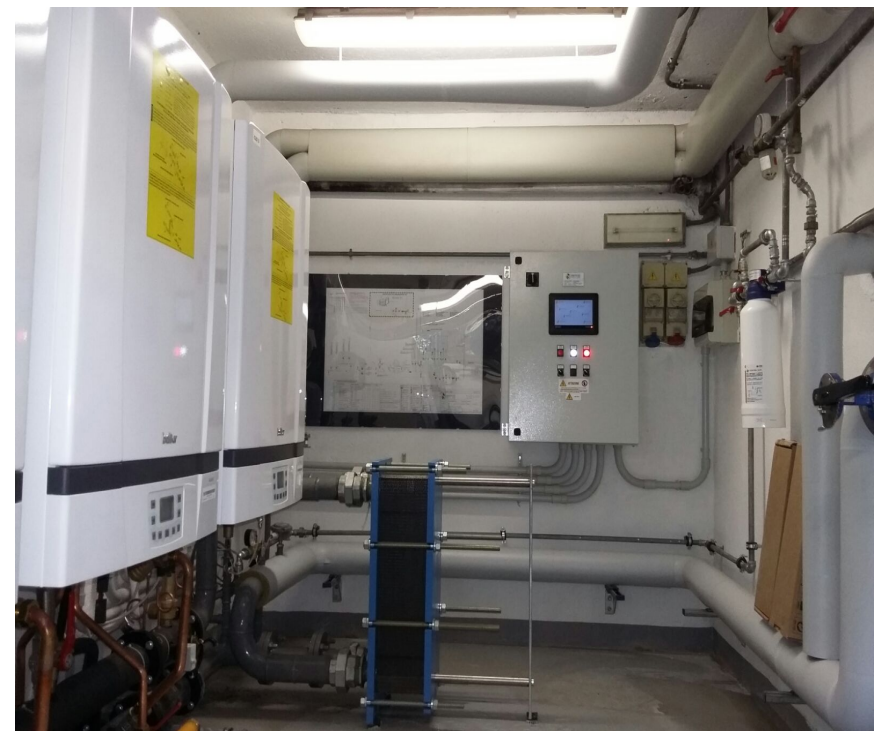
RIFACIMENTO CENTRALE TERMICA 345kW CONDOMINIO IN MUGGIO' (DOPO)
